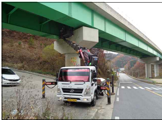
작업차량을 이용한 외관조사
