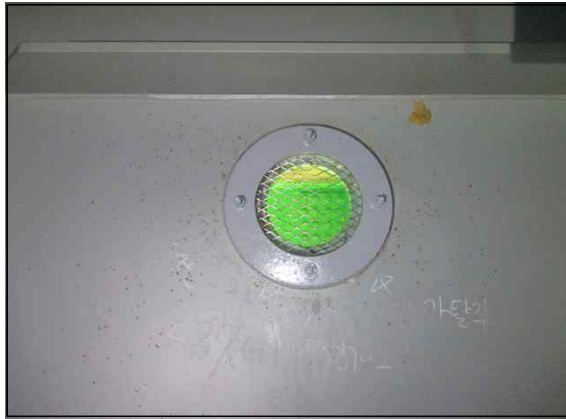
거더 내부 환기구 망 보수(S3 G1)
