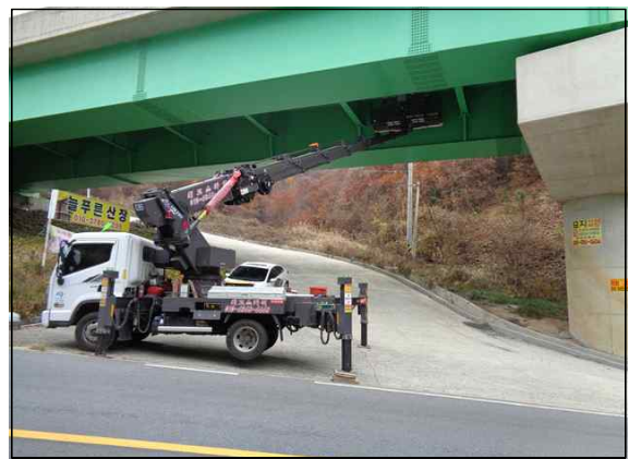
작업차량을 이용한 외관조사
