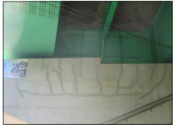
교각 코핑부 균열 보수현황(P1)
